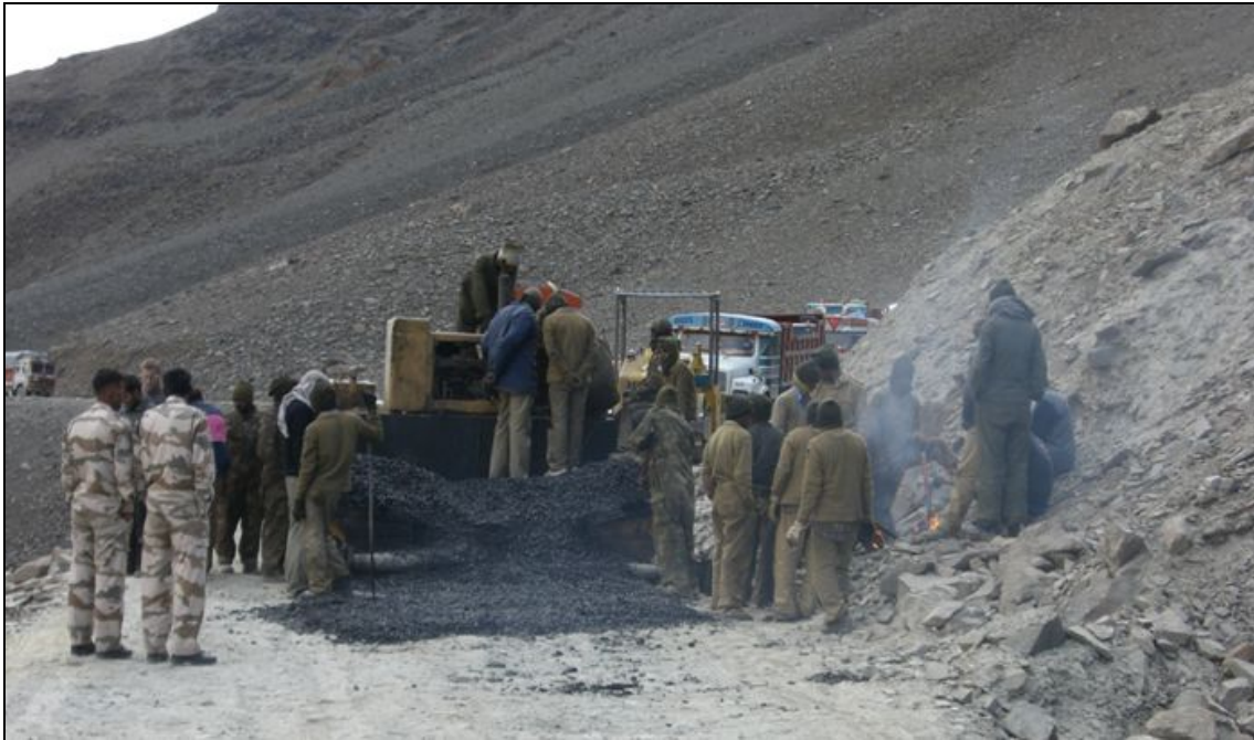
Abbildung 4: Straßenbau unterhalb des Baralachal La auf dem Manali-Leh-Highway, ca. 4700m üdM. (Photo: Florian Sander, 25.08.2007)
