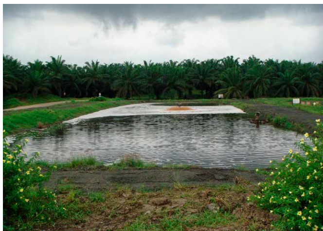
Das Abwasser der Palmölmühlen könnte genutzt werden um Biogas und organischen Dünger zu produzieren. Ein mit den Abwässern einer Palmölmühle (POME) gefülltes Auffangbecken in Sabah, Malaysia (Foto: Oliver Pye)
